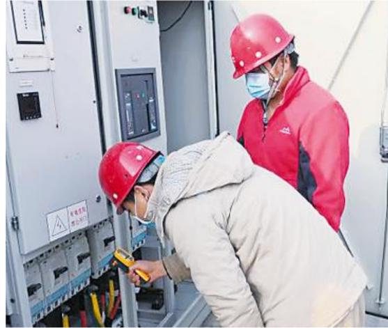
巡检设备时测试电缆接头的温度,防止过热
